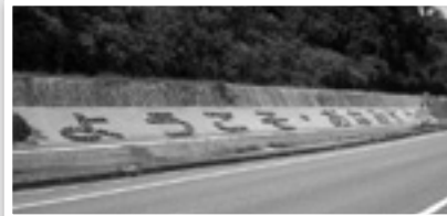
工事の一例です。
